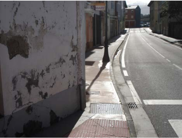
Estrechamiento itinerario peatonal por báculo alumbrado y por alineación acera de sólo 60 cm.
