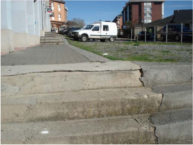
Vista general de la calle Rodrigo Yañez
