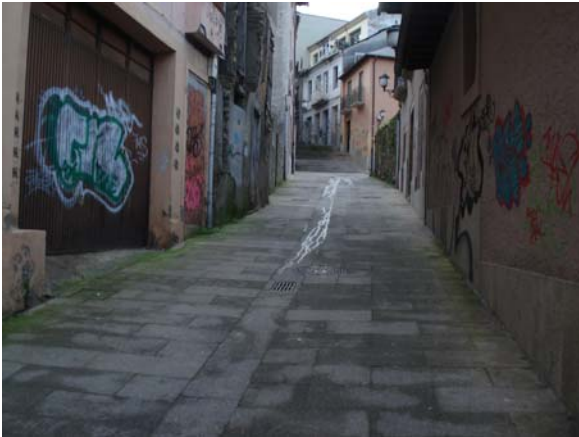
Tramo de plataforma única de fuerte pendiente
