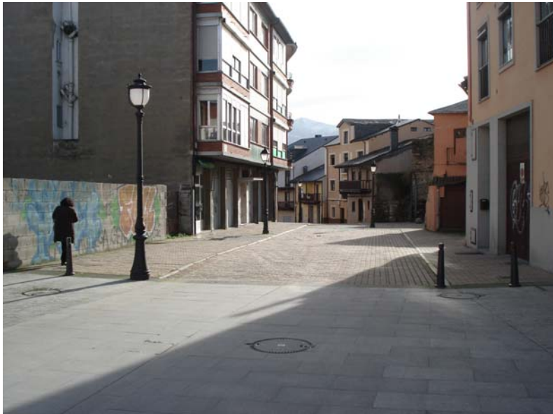
Vista del inicio de la calle desde la calle Los Jardines
