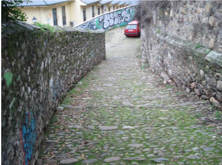
Vista general en tramo intermedio desde la plazuela inferior de C/ Flórez Osorio hasta cruce con la C/ Mirador
