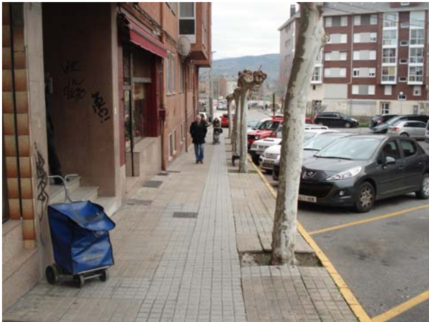
Puntualmente tramo de acera de itinerario accesible amplio
