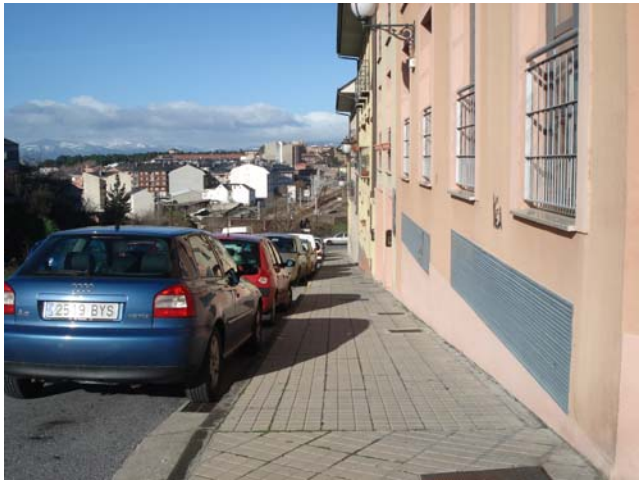
Acera derecha anchura de 1,95 m.
