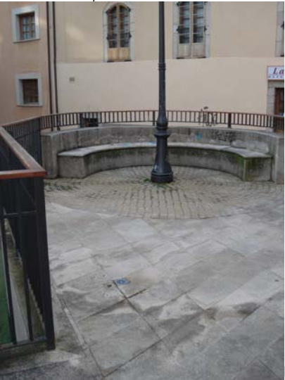
Ubicado en zona de pavimento diferenciado de adoquinado de granito.
