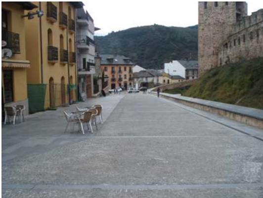
Vista tramo intermedio con pavimento de adoquinado
