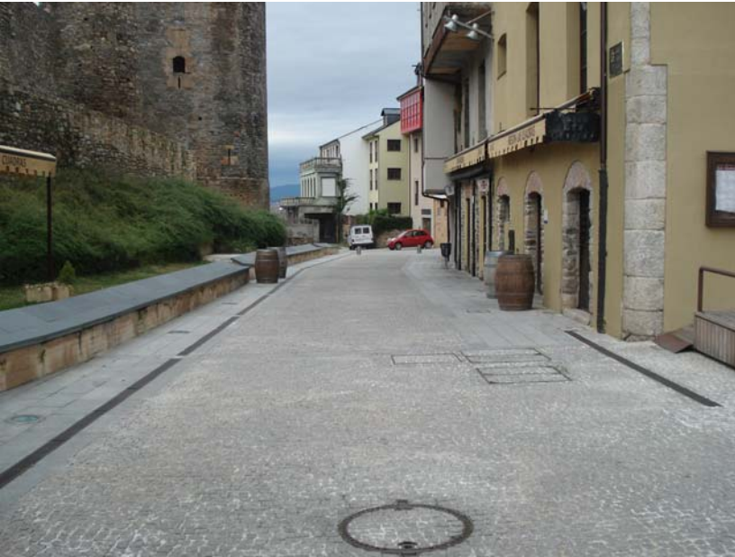
Vista inicial de la calle Tras La Cava desde la calle Gil y Carrasco
