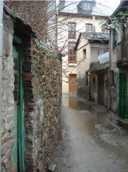
Ubicación de escalón y socavones en pavimento además de ramas de árbol privado invadiendo el espacio público a una altura menor a 2,20 m.
