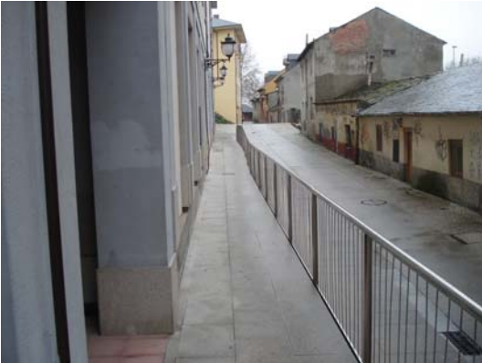
Tramo central. Ancho se reduce a 1,28 m.
