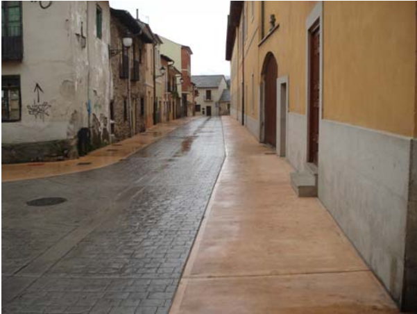
Vista de calle y sus pavimentos
