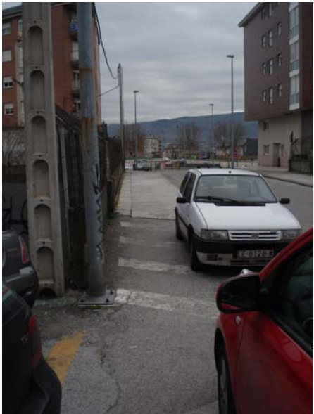
Convivencia indeseada entre aceras y aparcamientos en la misma alineación que impiden la circulación peatonal y mucho más la adaptada.
