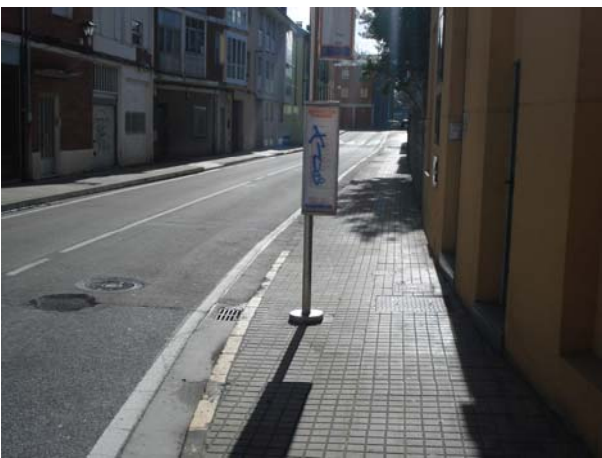
Estrechamiento itinerario peatonal por señal autobús
