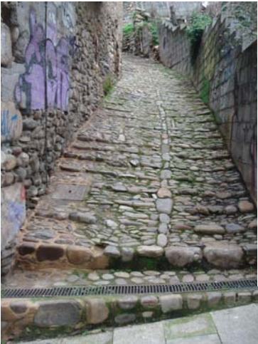
Inicio de la calle desde El Rañadero, incluso con 2 escalones.
