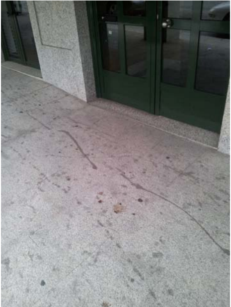
Detalle baldosa acera y pequeño desnivel para facilitar entrada a nivel en edificio
