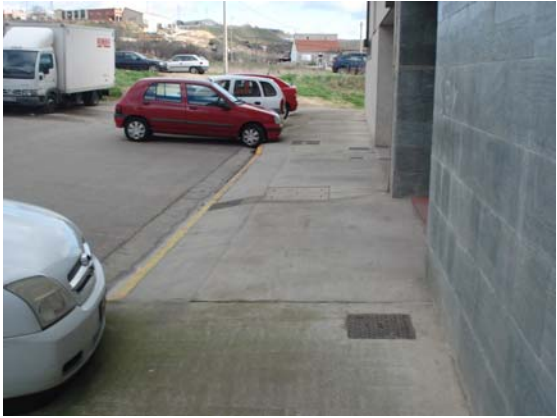
Tramo final en acera de hormigón bien acabado
