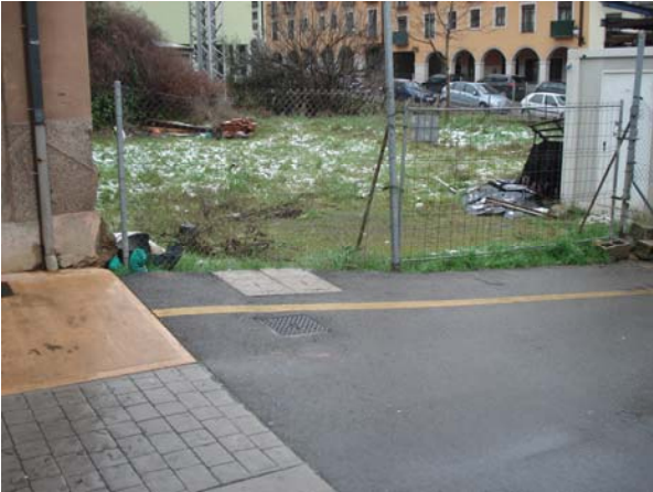
Detalle cambio de pavimentos enrasado entre los tramos inicial e intermedio
