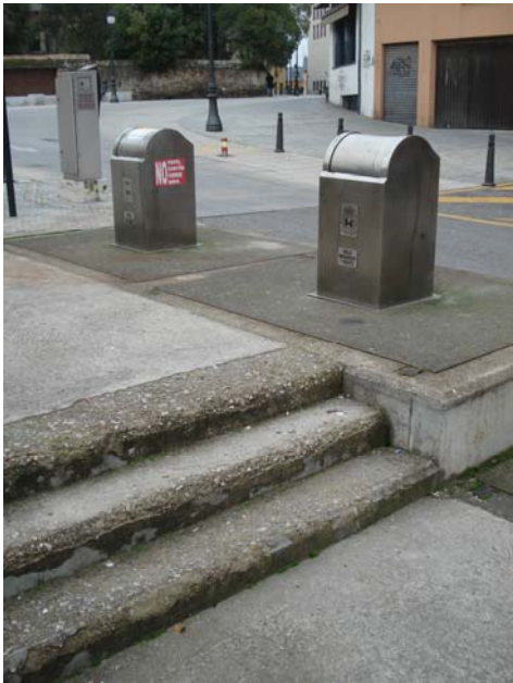
Acera en hormigón y con escalera sin detección ni barandillas
