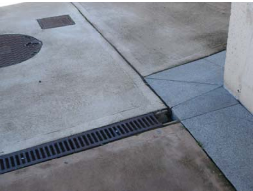
Rejilla corrida de pluviales en acera con abertura de 1,3 cm. y deterioros
