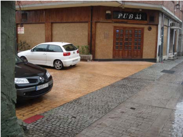
Espacio lateral enrasado y sus pavimentos
