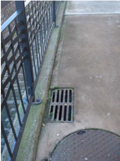
Rejilla corrida de pluviales en acera con abertura de 1,3 cm. y deterioros
