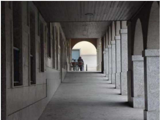
Las terrazas de las cafeterías, restaurantes o bares producen puntualmente estrechamientos en el itinerario accesible.
