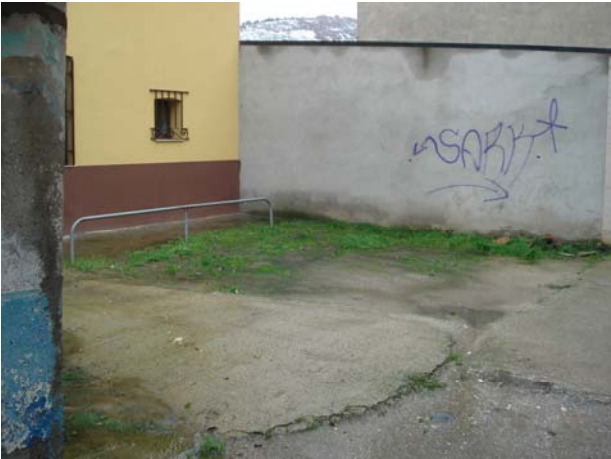
Espacio lateral mencionado y barandilla peligrosa
