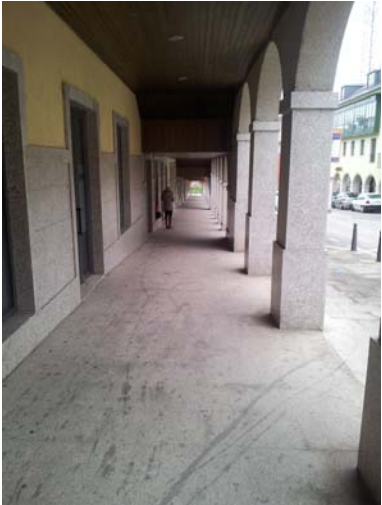
Acera en soportal lado izquierdo
