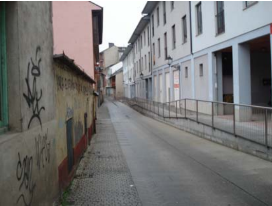
Visión general de la rampa o acera elevada lateral
