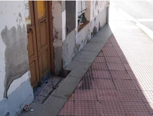
Escalón invadiendo espacio peatonal
