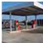
Instalación de Estaciones de Servicio
