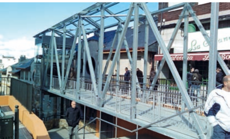
Salva una altura de casi cinco pisos entre la calle Guatemala y la avenida General Vives
