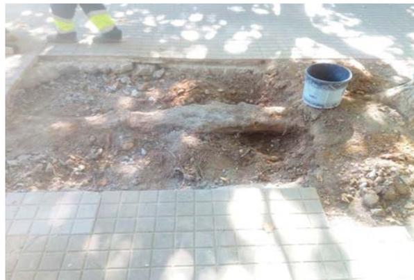
Figura 8. Sistema radicular de un plátano en formato "crecimiento libre" durante la reparación de la acera.
