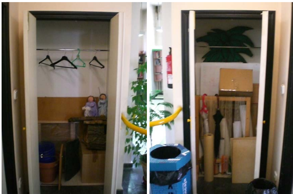
ARMARIOS QUE SE DEMOLERAN PARA PERMITIR EL DESEMBARCO DEL ASCENSOR EN LA PLANTA 1ª
