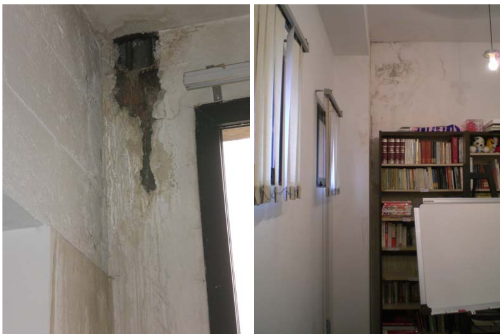
PUNTOS INTERIORES DE LA PLANTA SUPERIOR, EN LAS QUE SE DEBERÁN REPARAR LAS CONEXIONES DE LOS CANALONES Y LAS BAJANTES
